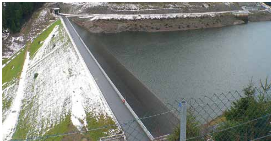
Die Talmauer eines Pumpspeicherkraftwerks in Thüringen. Kraftwerke dieser Art haben zwei Wasserreservoirs auf unterschiedlichem Höhengniveau. Zu Zeiten, in denen regenerative Energiequellen wie Solar- und Windkraftanlagen überschüssigen Strom erzeugen, wird das höhergelegene Wasserbecken aufgefüllt. In stromarmen Zeiten wird dann mittels Wasserkraftturbinen Energie erzeugt.
